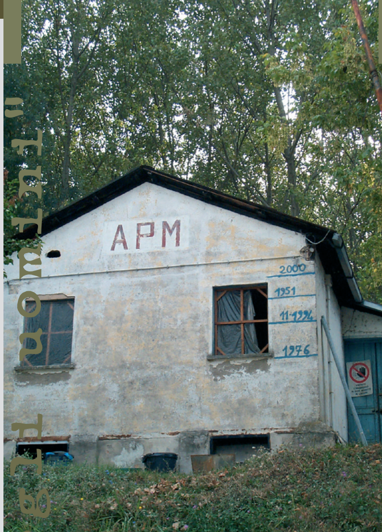
Alla confluenza del fiume Po e del fiume Oglio, una casa riporta segnate sui muri le altezze cui sono arrivate le acque durante le principali piene (foto Davide Papotti).
