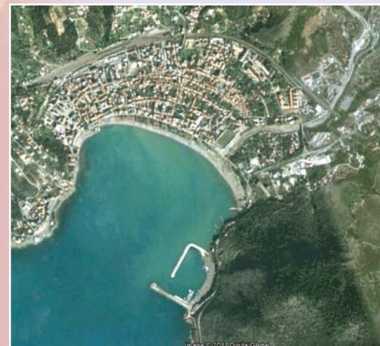
Fig. 3 - Immagine della baia e della cittadina di Sapri ripresa da satellite (cortesia Google Earth).
