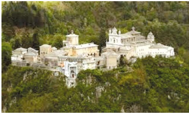
Fig. 9. Sacro Monte della "Nuova Gerusalemme", Varallo Sesia (Vc) - Fondato dal francescano Bernardino Caimi (1486) sul monte che domina Varallo, attraverso un percorso di 45 cappelle evoca la passione e la morte di Cristo.
