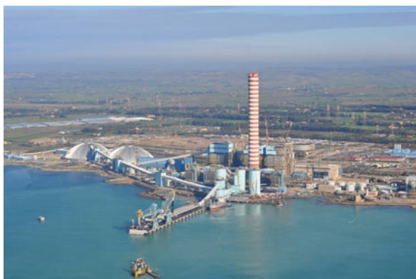
La centrale termoelettrica ENEL di Torrevaldaliga Nord vista dal mare. Si notano, intorno alla ciminiera, le strutture per l'attracco di navi, il trasporto e il rifornimento di carbone e i due caratteristici sili "coal dome" per lo stoccaggio del combustibile.
