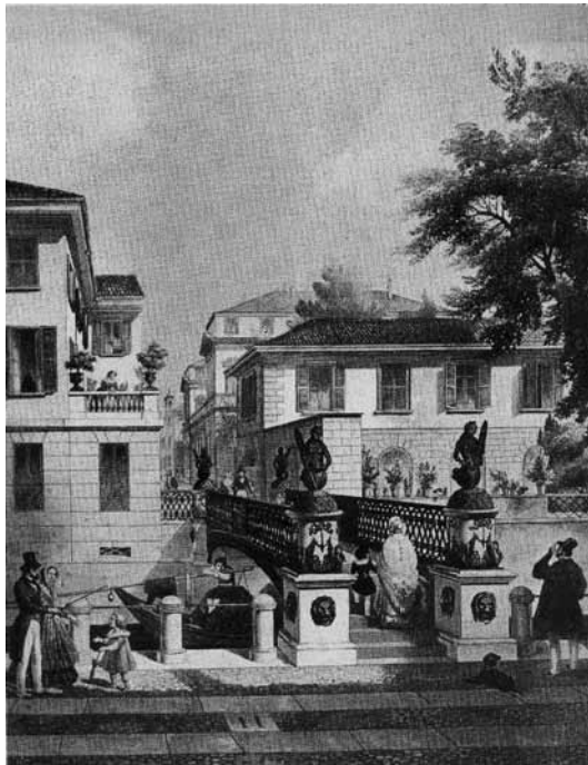
Fig. 3. Milano, via Visconti di Modrone, ponte delle Sirenette. Si tratta del primo ponte metallico costruito in Italia (1842), ora collocato nel cuore di parco Sempione.
