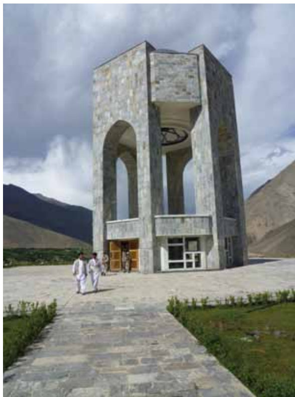
Fig. 4. In fondo alla valle del Panjshir, su un'altura, sta la tomba del Comandante Massoud. Eroe della resistenza contro i russi, Leader dell'Alleanza del Nord, ucciso da Al Qaeda pochi giorni prima dell'11 settembre 2001. Idolatrato dal suo popolo riposa sotto un'enorme cupola in un sacello coperto da una teca di cristallo, piena di sabbia della valle.
