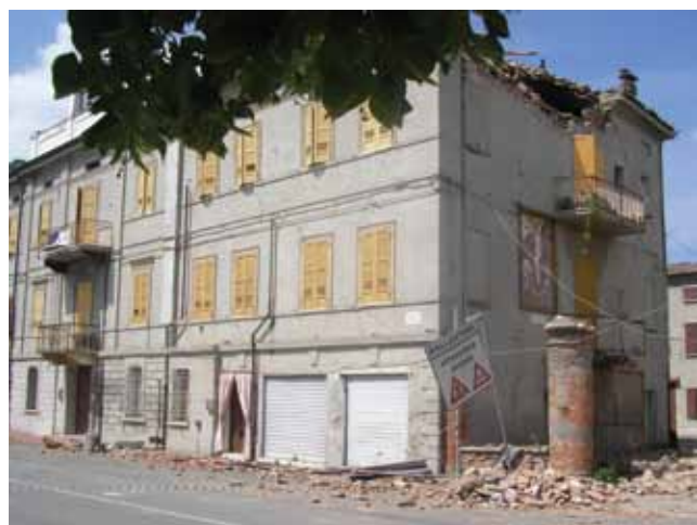
Fig. 3. Edificio lesionato all'ingresso della zona rossa di Concordia sulla Secchia (MO).
