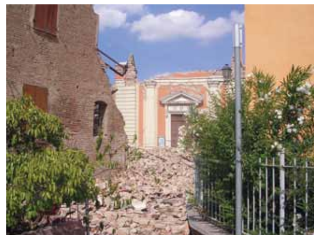
Fig. 6. Chiesa nel centro storico di San Felice sul Panaro (MO).
