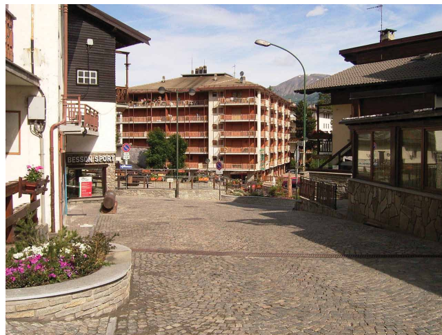
Fig. 3. Sauze d'Oulx (1509 m, 1157 residenti) è un buon esempio di un comune in forte accrescimento demografico (78,8% dal 1901 al 2010), dovuto al ruolo di grande stazione invernale nel contesto del comprensorio della Via Lattea. L'intensa urbanizzazione dai primi anni '60 alla fine degli anni '70, oltre a conferire al centro un aspetto tipicamente urbano, ha fortemente limitato la vista sulle Alpi Cozie settentrionali, oggi possibile solo da alcuni angoli del piccolo centro storico.
