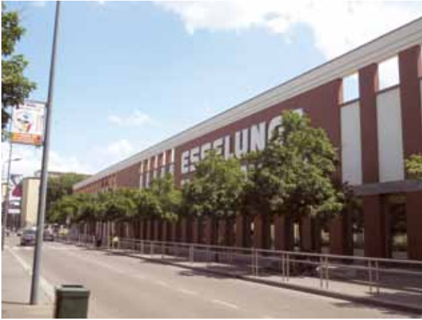
Fig. 15. Via Ripamonti, vicino allo scalo ferroviario di Porta Romana: un superstore ha preso il posto delle vecchie fabbriche (Foto: M.A. Clerici, 2014).
