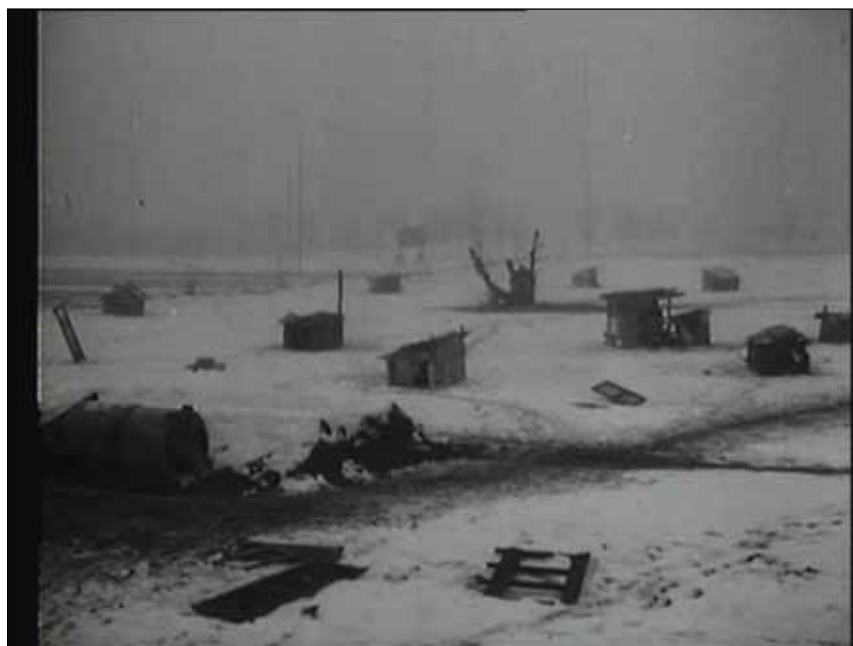
Fig. 2. Il «Caos primigenio», lo spazio in-significante delle baracche individuali.
