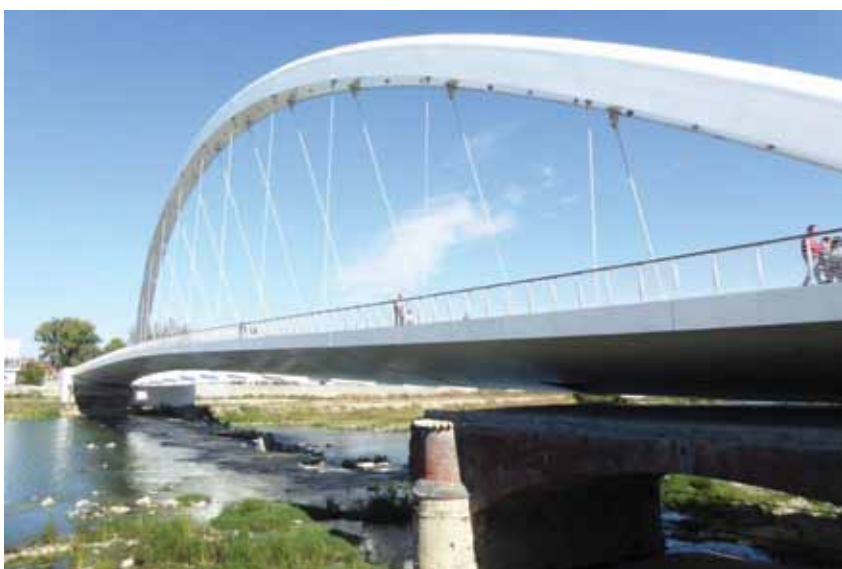
Fig. 5. Alessandria, ponte Meier. Si tratta di una struttura costruita interamente in acciaio, con un'unica campata, dotata di un arco centrale alto 30 metri per l'assorbimento dei carichi, di una piattaforma pedonale e di una piattaforma per il traffico veicolare. Questo manufatto - opera del grande architetto Richard Meier inaugurata il 23 ottobre 2016 - ha sostituito il precedente ponte abbattuto perché ritenuto da molti causa della disastrosa alluvione del Tanaro del 1994.
